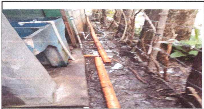
Foto 5: Sustitución de tubería principal.
