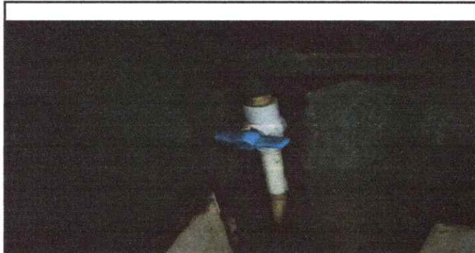
Foto 3: Sustitución de llave de paso de los baños.
