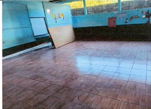
Foto 14: Sustrucción de piso de torta de concreto, salón de Primero B
