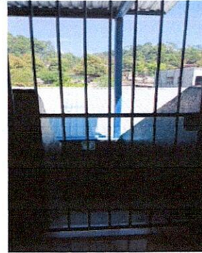
Foto 20: Sustitución de puerta, de las gradas del segundo nivel
