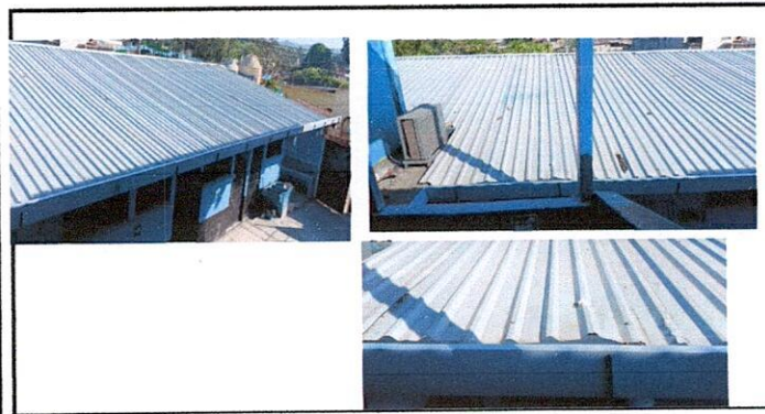
Foto 11: Sustrucción de canal de metal
