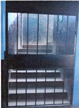
Foto 21: Mantenimiento, pintura y cambio de chapa, puerta de las gradas 2do nivel
