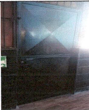
Foto 23: Mantenimiento, pintura y cambio de chapa dirección
