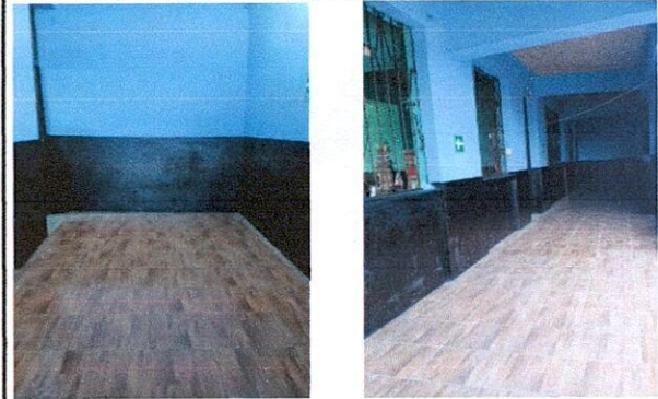
Foto 22: Sustitución de piso de torta de concreto, corredor del 1er. Nivel
