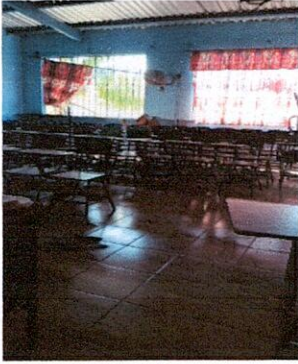
Foto 19: Sustitución de piso de torta de concreto, salón sexto primaria
