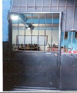
Foto 2: Sustitución de puerta, 1ro. Grado sección "C"
