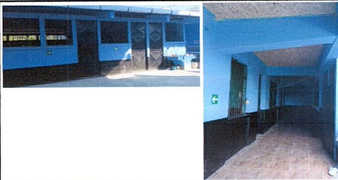
Foto 17: Pintura en muros exteriores
