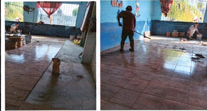
Foto 19: Sustitución de piso de torta de concreto, salón sexto primaria
