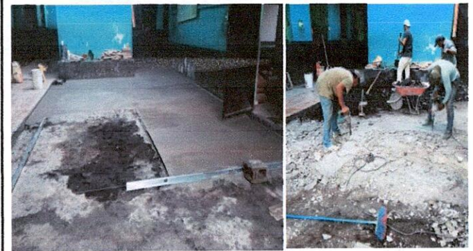
Foto 15: Reparación de piso de concreto
