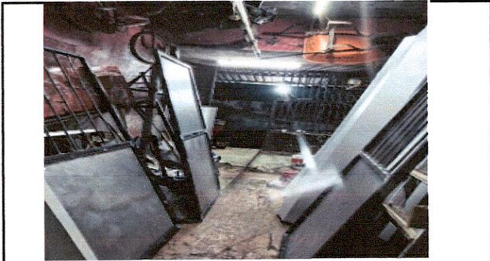
Foto 7: Sustrucción de puerta para bodega de instrumentos deportivos
