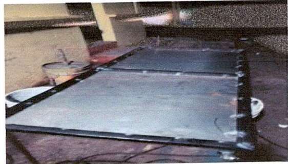
Foto 6: Sustitución de puerta para 1ro. A
