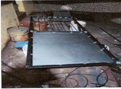
Foto1: Sustitución de puerta, 4to. Grado sección A y B
