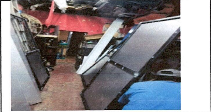
Foto 8: Mantenimiento y cambio de chapa para puerta de 2do. Grado sección A y B
