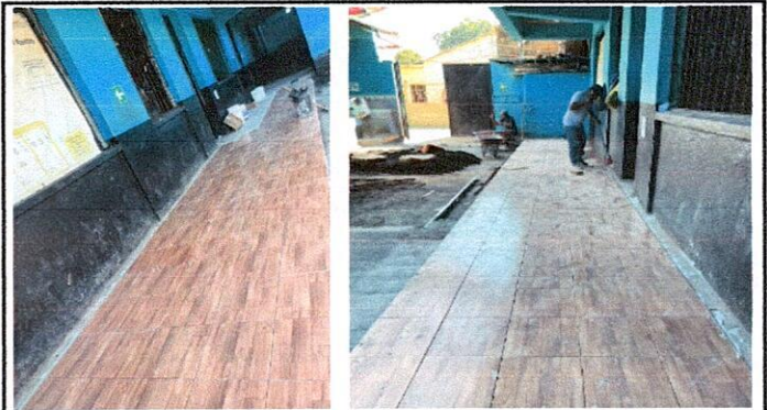
Foto 22: Sustitución de piso de torta de concreto, corredor del 1er. Nivel
