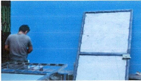
Foto 21: Mantenimiento, pintura y cambio de chapa, puerta de las gradas 2do nivel
