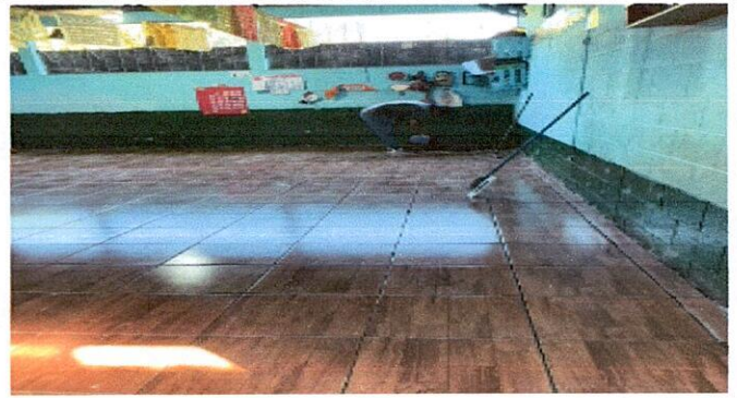
Foto 14: Sustitución de piso de torta de concreto, salón de Primero B
