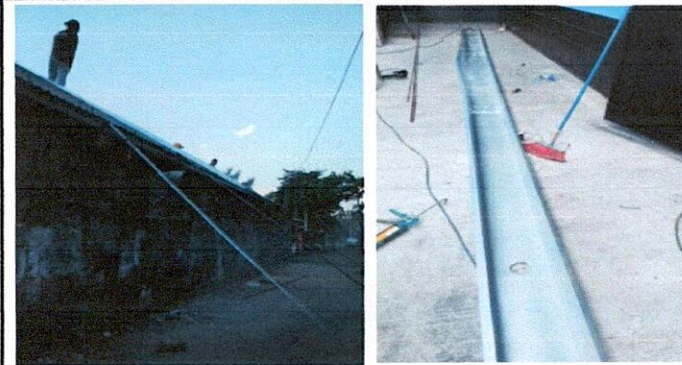
Foto 13: Sustitución de canal de metal
