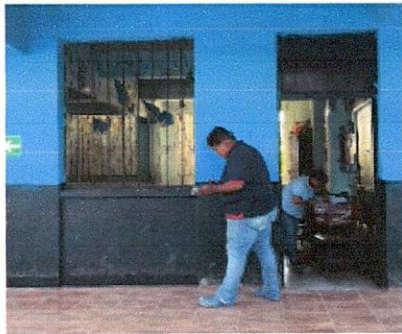
Foto 23: Mantenimiento, pinutra y cambio de chapa dirección
