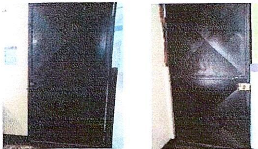
Foto 23: Mantenimiento, pintura y cambio de chapa, de dirección.
