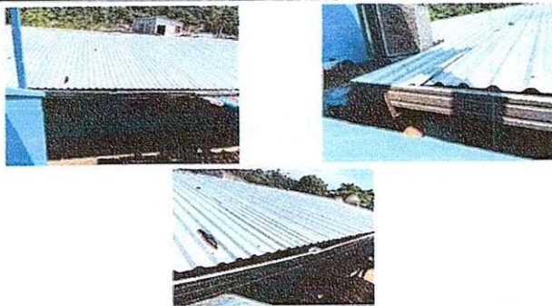
Foto 11: Sustitución de canal de metal
