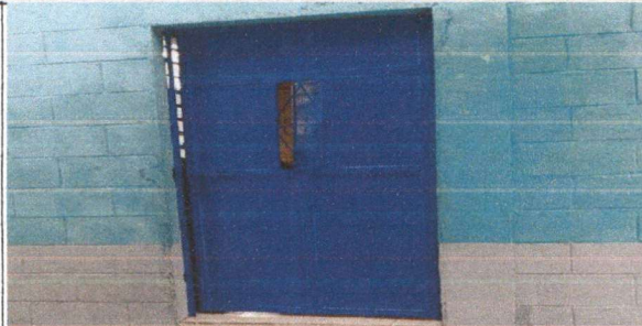
FOTO 5: MANTENIMIENTO ESTRUCTURA DE PUERTAS
