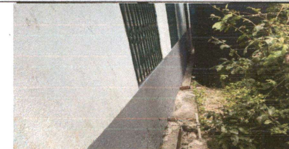
FOTO 6: IMPERMEABILIZANTE A PARED
