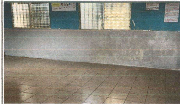
Foto 4: REPARACIÓN DE PAREDES
