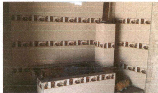
Foto 3: REPARACION O SUSTITUCIÓN DE LORENA A ESTUFA RURAL.
