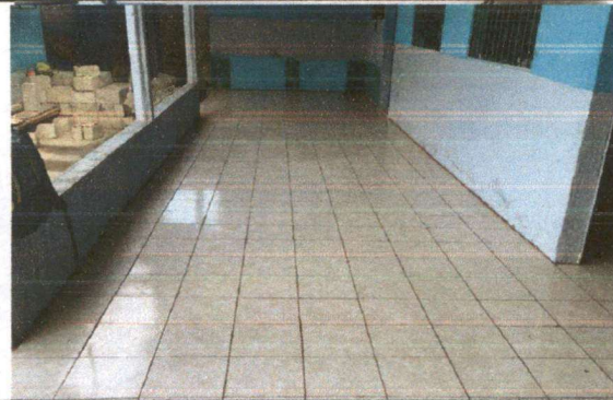
Foto 1: REPARACION DE PISO
