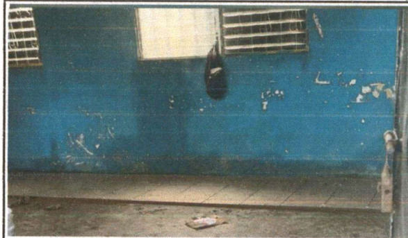
Foto 4: REPARACIÓN DE PAREDES
