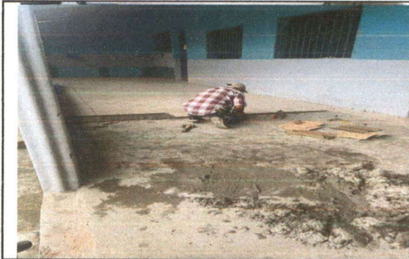
Foto 1: REPARACION DE PISO
