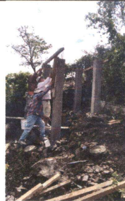
Foto 4: INSTALACIÓN DE CISTERNA
