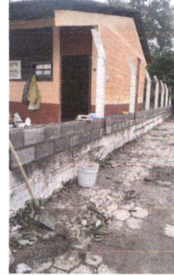
Foto 2: CERCO O MURO PERIMETRAL
