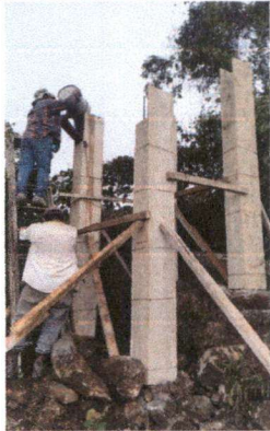
Foto 5: INSTALACIÓN DE CISTERNA
