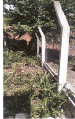
Foto 6: CERCO O MURO PERIMETRAL
