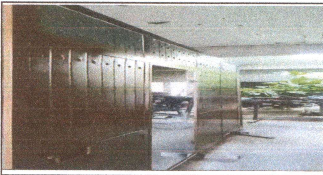
Foto 6: Reparación de portón
