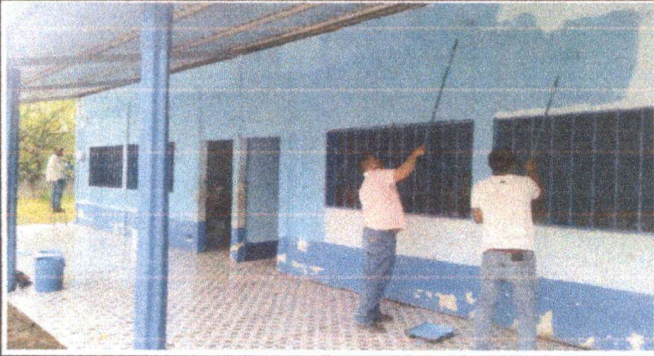
Foto 1: Pintura en muros interior y Exterior
