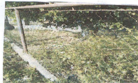
Foto 5: Muro con malla galvanizada
