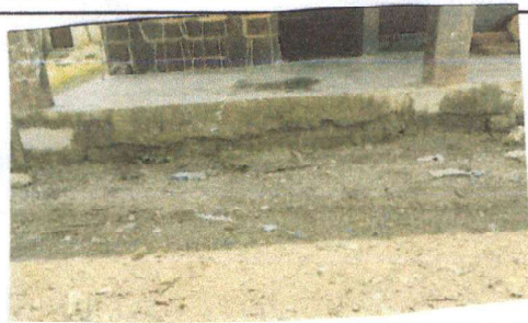
Foto 3: Área de Banqueta
