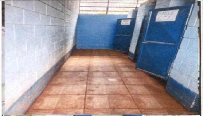
Foto 2: se Instalo puertas metalicas.
