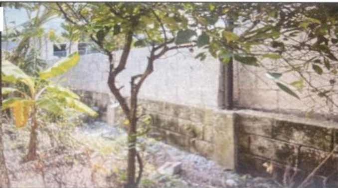
Foto 5: se sustituyo el alambre, telametalica por block
