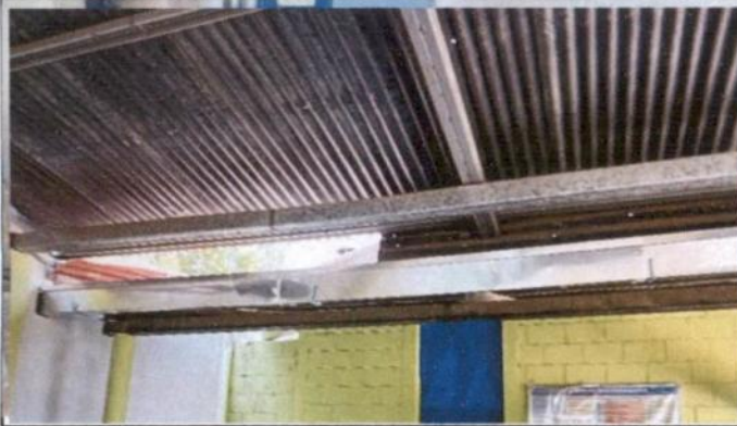
Foto 1: se sustituyo el canal por de metal área del comedor escolar
