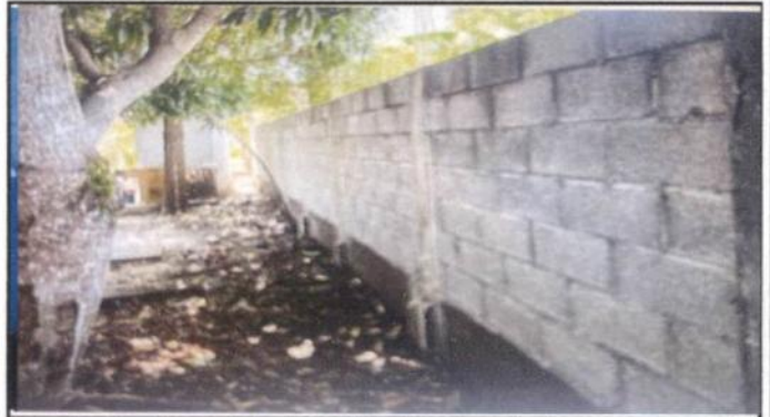
Foto 4: se sustituyo el alambre, telametalica por block
