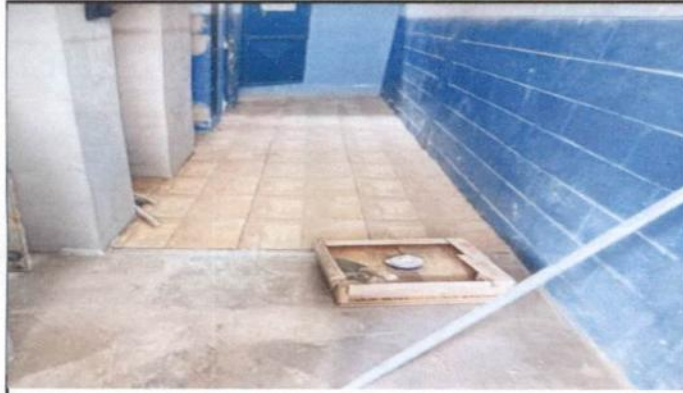
Foto 1: instalación de piso cerámico en los baños .
