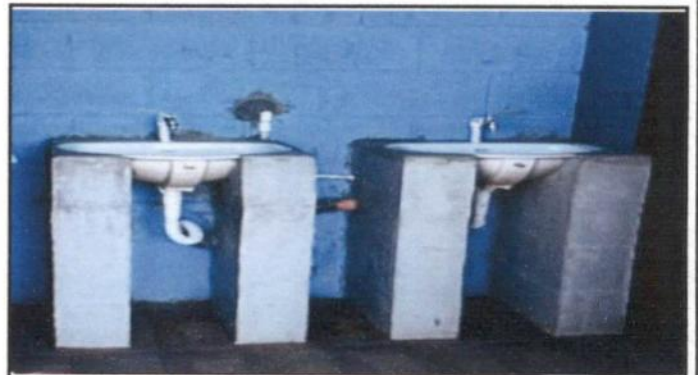
Foto 4: Instalacion de labamanos.
