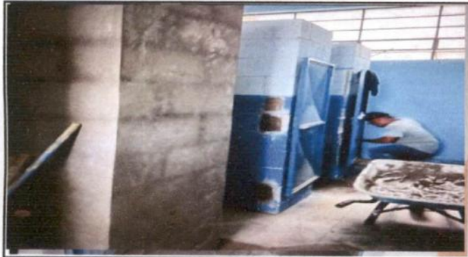
Foto 3: Instalacion de puertas metalicas.
