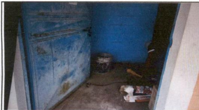
Foto 3: Instalacion de puertas metalicas.
