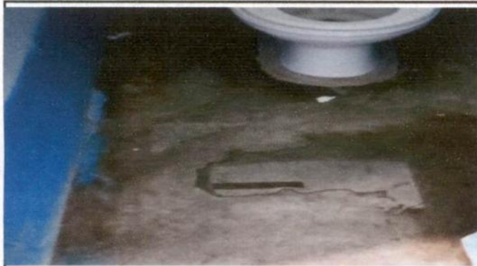
Foto 1: Instalacion de piso ceramico en los baños
