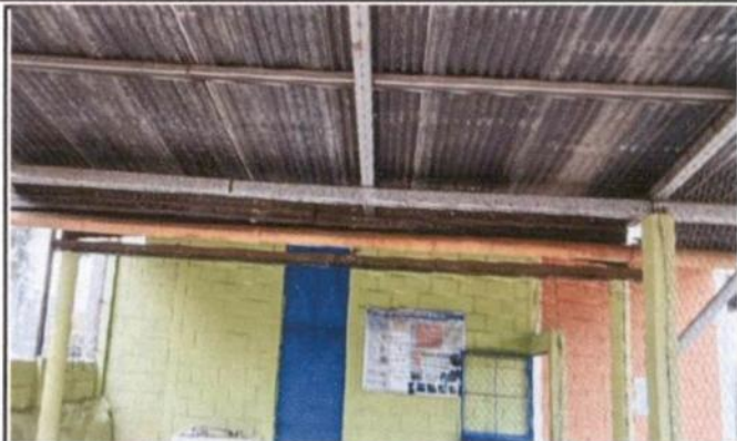
Foto 2: sustitucion de canal de metal área del comedor escolar
