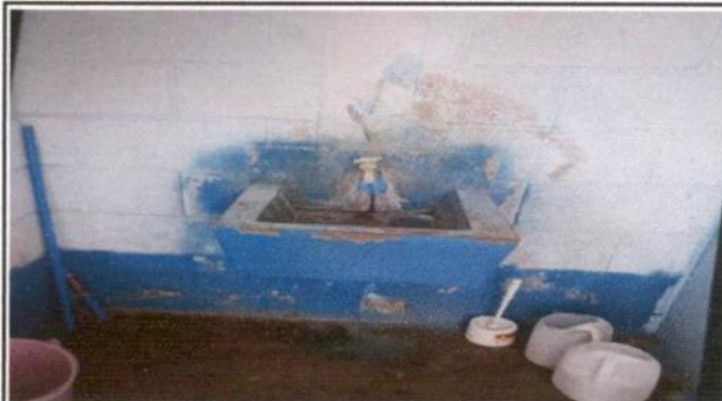
Foto 4: Instalacion de labamanos.
