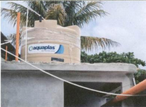
Foto 3: Instalación de Cisterna.
