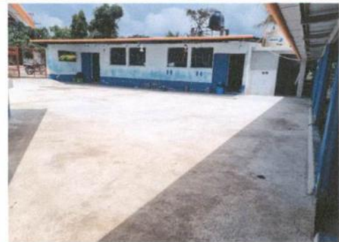
Foto 6: Losa de patio.
