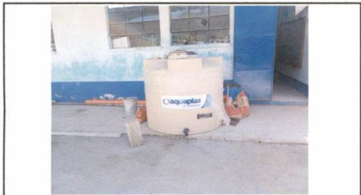
Foto 3: Instalación de Cisterna.
