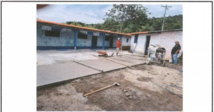
Foto 6: Losa de patio.
