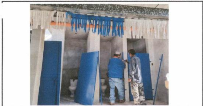
Foto 5: Sustitución de puertas de servicios sanitarios.
