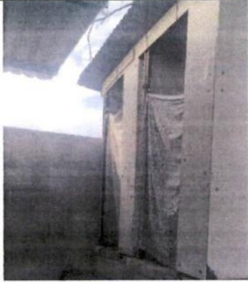
Foto 1: Sustitucion de puertas de servicios sanitarios.
