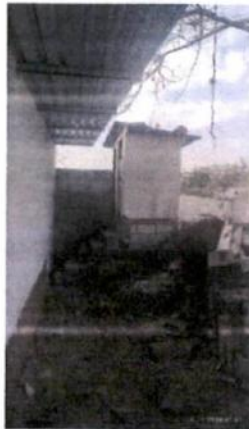
Foto 3: instalacion de cisterna.
