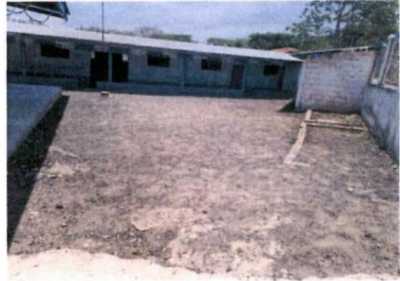
Foto 2: Losa de Patio.
