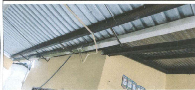
Foto 3: Canales y Bajadas de Agua Pluvial
