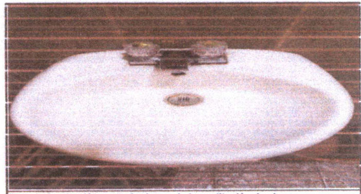
Foto 6: Situación posterior luego de la sustitución de chorro en lavamanos.
