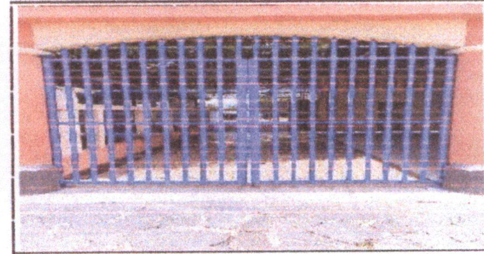
Foto 12: Situación posterior del portón luego del mantenimiento de pintura.
