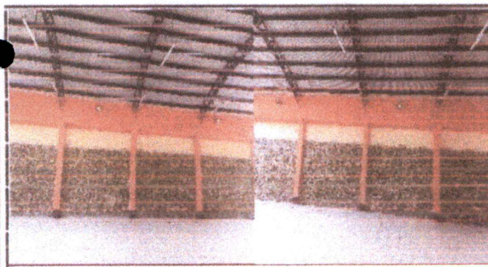
Foto 5: Situación posterior luego de la sustitución de lámparas LED.
