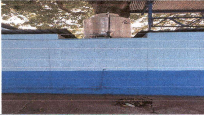
Foto7: Situación durante la reparación de cisterna.
