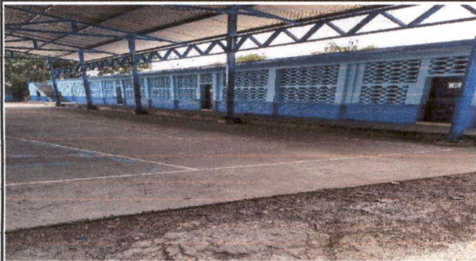
Foto1: Situación de muros exteriores durante el remozamiento de pintura
