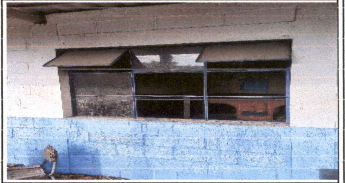
Foto 8: Situación durante la instalación de balcón y vidrios en ventanal.
