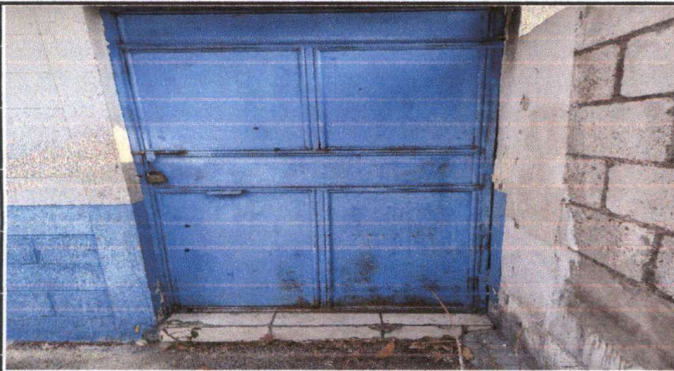
Foto 9: Situación durante la sustitución de puerta en cocina.
