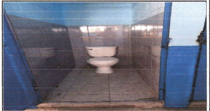
Foto 10: Situación durante la sustitución de piso y asulejo en baños.
