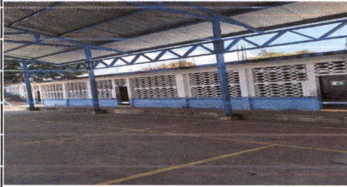
Foto 1. Muros exteriores previos al remozamiento de pintura de muros exteriores.
