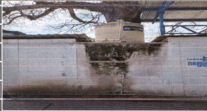
Foto 7. Situación de cisterna previo a nueva instalación.
