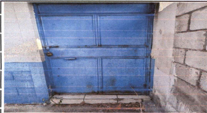
Foto 9. Situación de puerta previ a sustitución.
