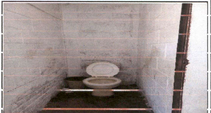
Foto 10. Situación de sanitarios previo a sustición de piso, asulejo e inodoro
