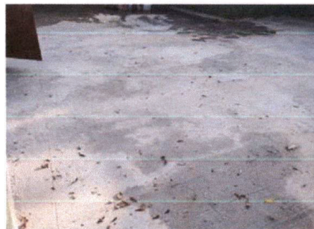
Foto 2: LOSA DE PATIO. NIVELACIÓN DE TERRENO. SUSTITUCIÓN DE PISO DE TORTA DE CONCRETO.
