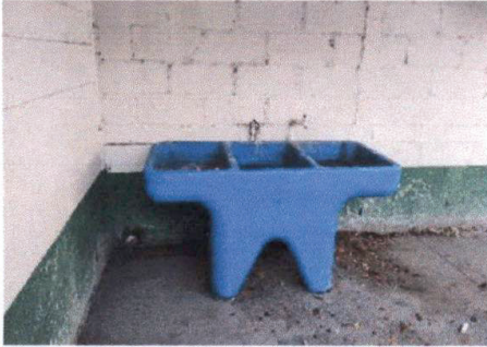
Foto 1: DESINSTALACIÓN E INSTALACIÓN DE PILA QUE SE ENCUENTRA EN EL PATIO DEL ESTABLECIMIENTO EDUCATIVO.
