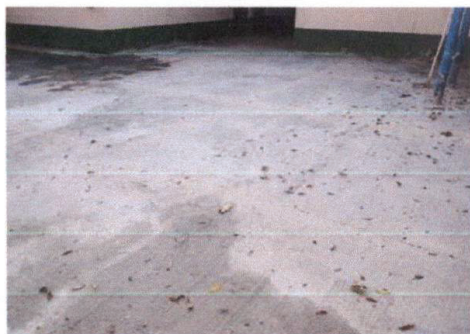
Foto 1: LOSA DE PATIO. NIVELACIÓN DE TERRENO. SUSTITUCIÓN DE PISO DE TORTA DE CONCRETO.
