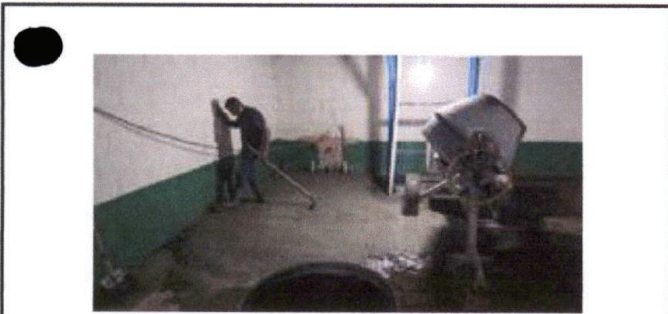
Foto 5: LOSA DE PATIO. SUSTITUCIÓN DE PISO DE TORTA DE CONCRETO.
