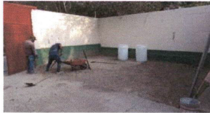
Foto 2: LOSA DE PATIO. NIVELACIÓN DE TERRENO
