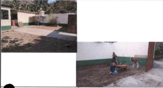
Foto 1: LOSA DE PATIO. NIVELACIÓN DE TERRENO
