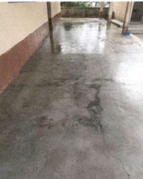
Foto 5: Estado inicial de piso de torta de concreto
