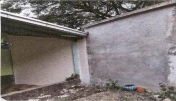
Foto 3: Repellado de una parte de muro perimetra, colocado un canal para agua plubial.
