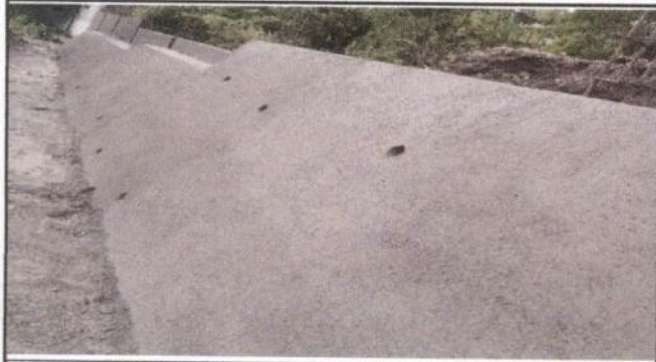
Foto1: Muro de contención ya terminado
