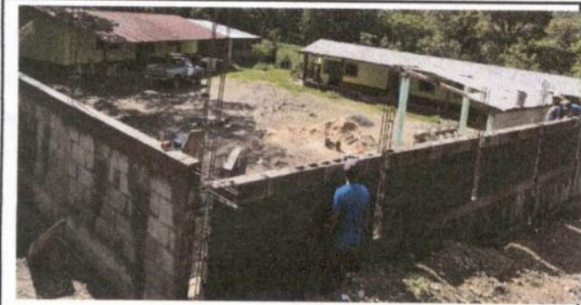
Foto 3: Muro perimetral en proceso, lado de enfrente, parte de la calle
