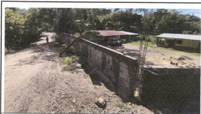
Foto 4: Muro perimetra en proceso, lado lateral derecho, lado de la carretera
