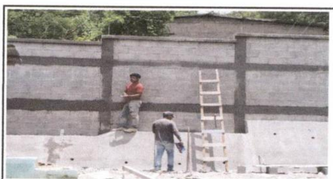
Foto 6: Tallado del muro perimetral.
