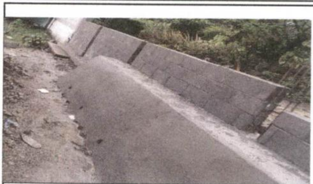
Foto 2: Comienzo ya de muro perimetral
