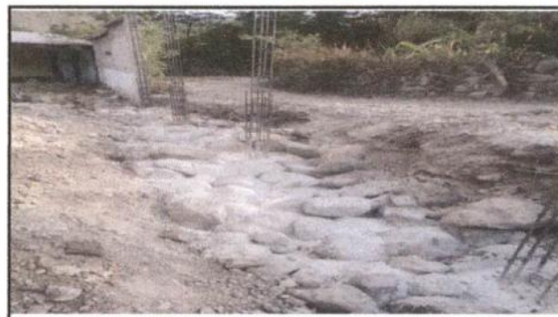
Foto 6: Fundición de cemento, con piedra y mezcla con cemento, arena y pedrín.
