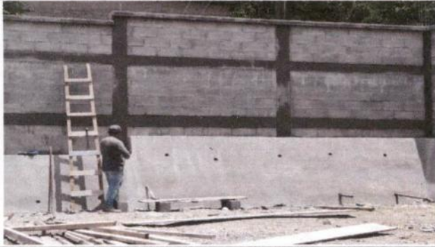
Foto 1: Terminación de tallado de muro perimetral
