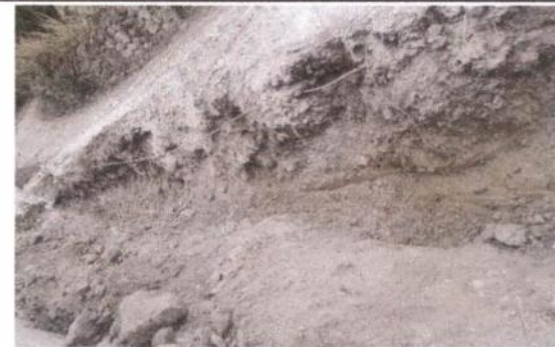
Foto 4: Zanjo ya terminado
