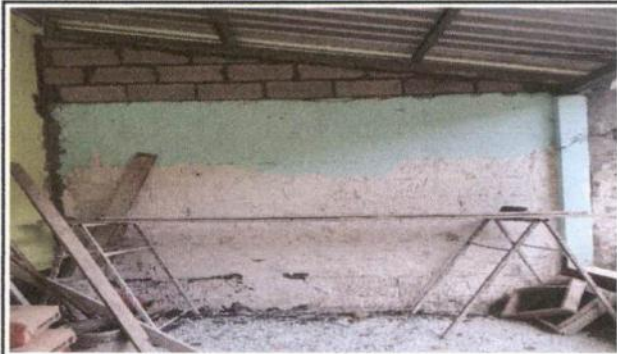
Foto 2: Proceso de reparación de pared del corredor.
