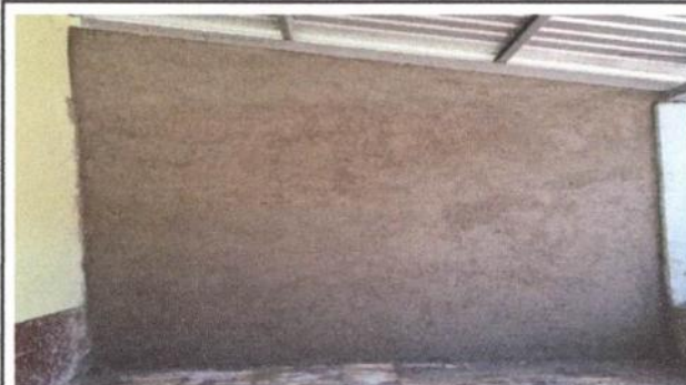
Foto 4: Terminado repello de pared del corredor.
