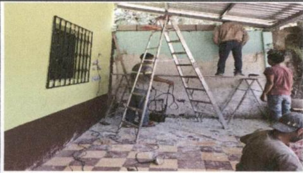
Foto1: Reforzando pared del fondo, corredor.
