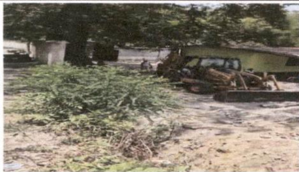
Foto 3: Comienzo del zanjo con máquina escavadora
