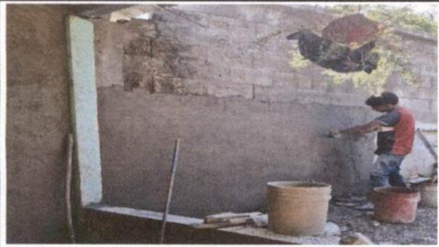
Foto 3: Repellado de pared, parte del muro perimetral.
