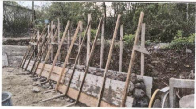
Foto 3: Fundición de cemento con piedra, parte del muro de contención
