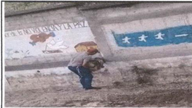
Foto1: Derribando muro en mal estado
