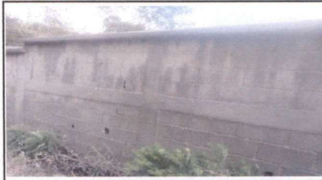
Foto 4: Muro perimetral vista por fuera, lado de la carretera.
