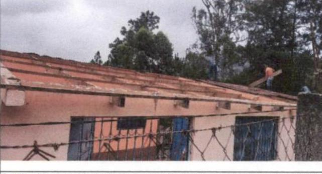
Sustitución de cubierta de lámina por lámina troquelada y sustitución de estructura de soporte de madera por estructura de metal.
