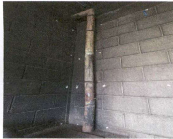
Foto 3: Chimenea de hornilla completamente rota.
