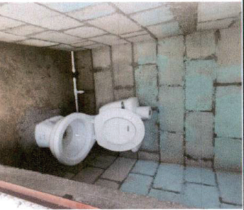
Foto 5: Cambio de sanitario de niño en su 100%
