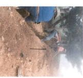
Foto 3: Relizando la zanja para colocar la tuburia de 1 1/4 que se compró para el proyecto de agua potable.
