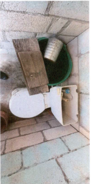
Foto 5: Sustituir la taza del baño.
