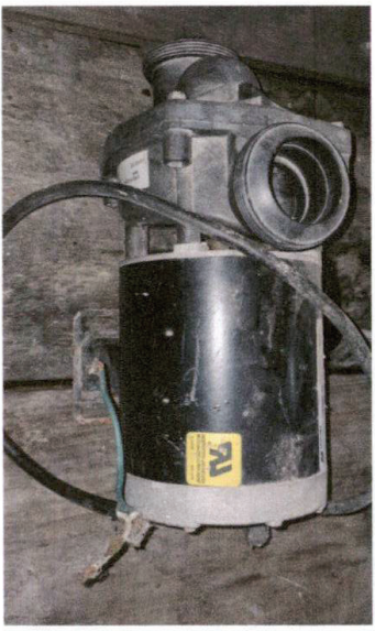
Foto 8 Sustitución de bomba de agua.
