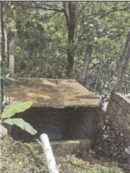
Foto 5: Reparación de fosa septica, repello, pared y entronque para su uso
