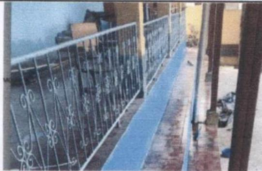
Foto 9: Instalación final de tres barandas. Con soldadura reforzada.
