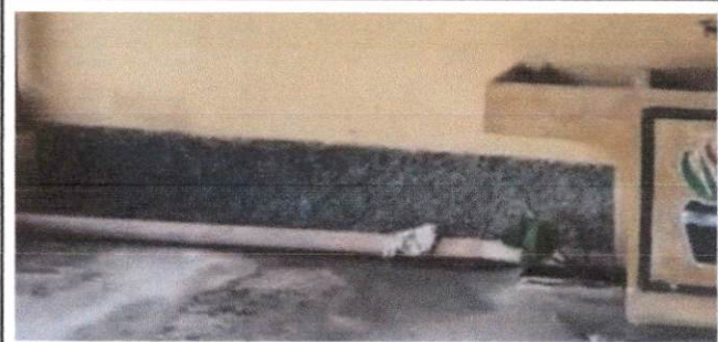
Foto 12: Sustitución de tubería principal PVC
