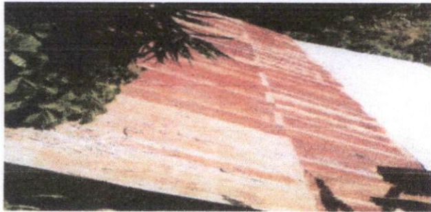
Foto 1: Sustitución de lámina, por lámina troquelada
