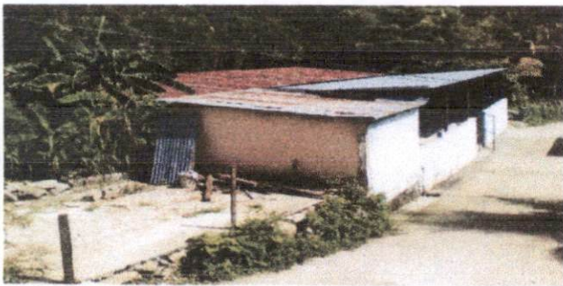
Foto 13: Reparación de muro perimetral con block, tubo hg y malla galvanizada con soleras.
