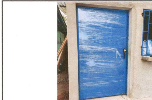
Foto 4: Sustitución de puerta de metal
