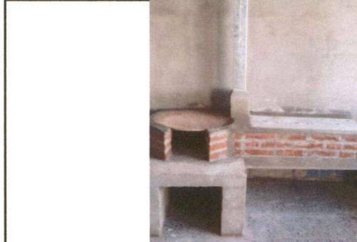
Foto 2: Sustitución de bases para estufa, colocación de plancha y chimenea
