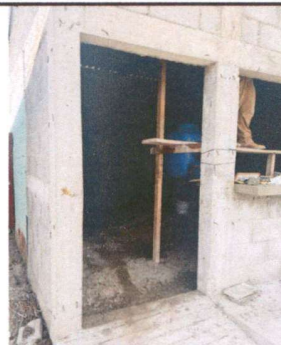
Foto 4: Sustitución de puerta de metal
