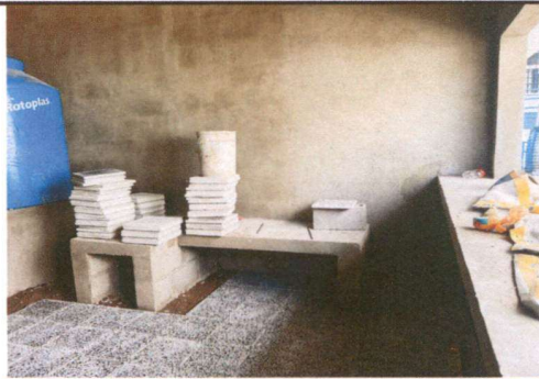
Foto 2: Sustitución de bases para estufa, colocación de plancha y chimenea
