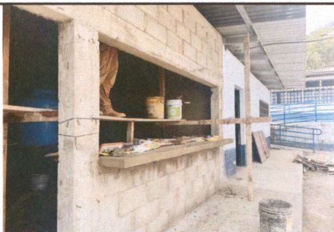
Foto 5: Mantenimiento de balcón de cocina
