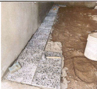
Foto 3: Colocación de piso de granito en cocina
