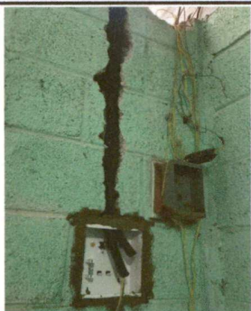
Foto7: Reparación de sistema eléctrico
