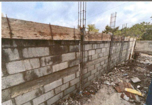
Foto 9: Reparación de muro perimetral de block
