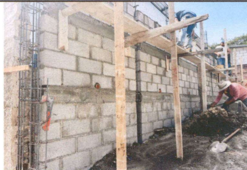
Foto 10: Reparación de muro perimetral de block
