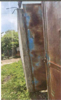
Foto 9: Reparación de muro perimetral de block
