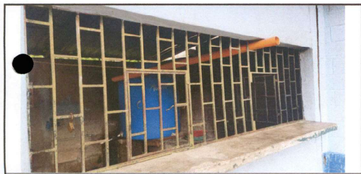
Foto 5: Mantenimiento de balcón de cocina
