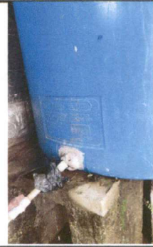
Foto 8: Sustitución de accesorios depósito de agua
