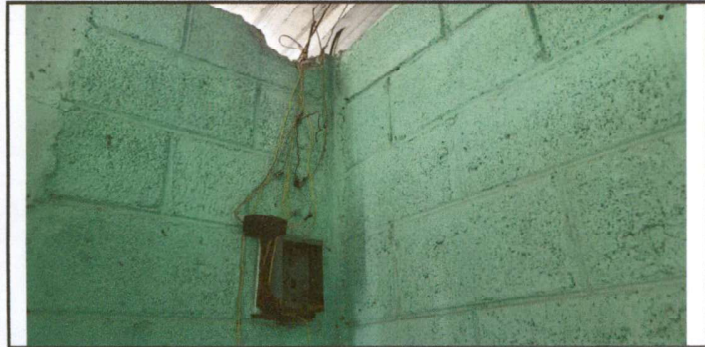
Foto 7: Reparación de sistema eléctrico
