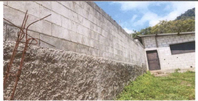
Foto 10: Reparación de muro perimetral de block
