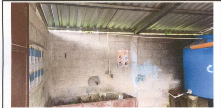
Foto1: Remozamiento de muros de cocina
