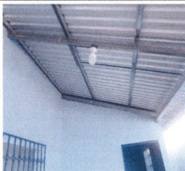
Foto 15: Sustitución de Sistema Eléctrico
