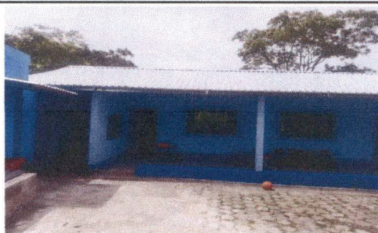
Foto 18: Sustitución de Lámina
