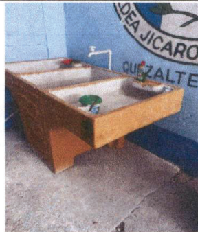
Foto 16: Sustitución de Pila de Concreto
