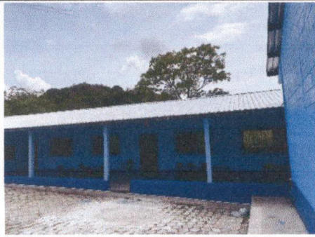
Foto1: Sustitución de Lámina y estructura de metal
