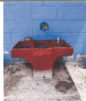
Foto 6: Sustitución de Pila de concreto para niños
