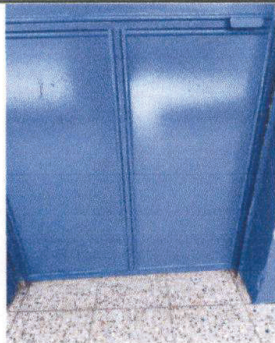
Foto1: Sustitución de Lámina y estructura de metal
