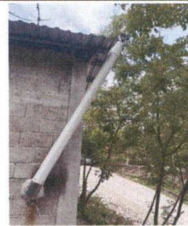
Foto 12: Sustitucion de Chimenea
