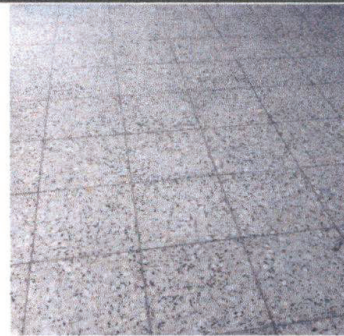
Foto 4: Sustitucion de piso
