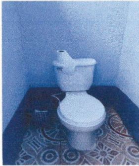
Foto 9: Sustitución de Sanitario
