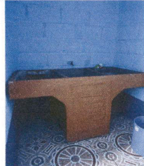
Foto 10: Sustitución de Pila de Concreto
