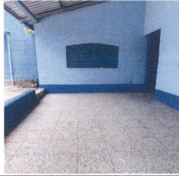
Foto 8: Pintura de Interior y Exterior
