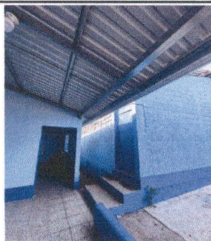
Foto 13: Sustitución de canal
