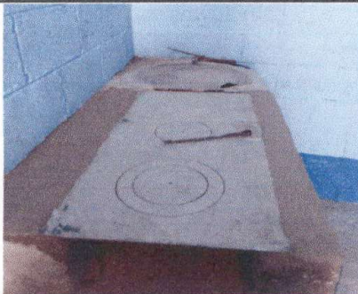
Foto 11: Sustitución de plancha
