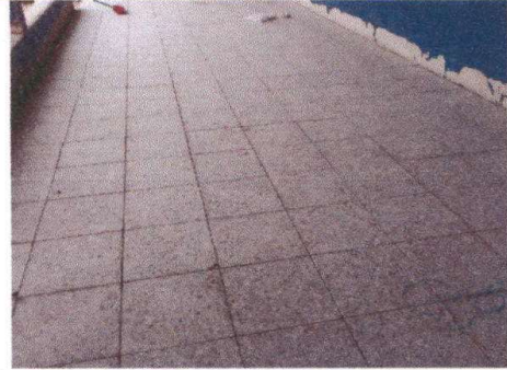
Foto 4: Sustrucción de piso
