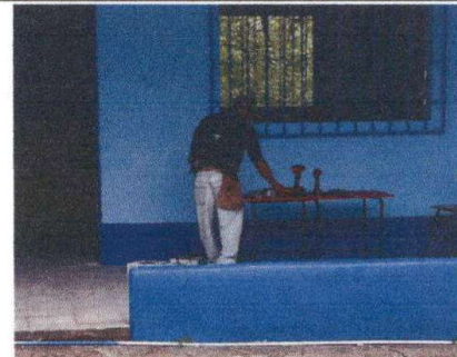
Foto 6: Sustitución del Sistema Eléctrico
