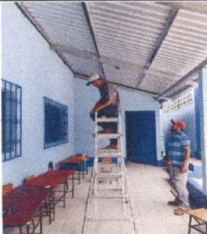
Foto 15: Sustitución de sistema eléctrico
