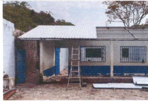
Foto 18: Sustitución de lámina
