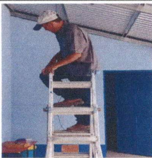
Foto 5: Sustitución del Sistema Eléctrico
