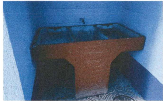
Foto 10: Sustitución de pila de concreto
