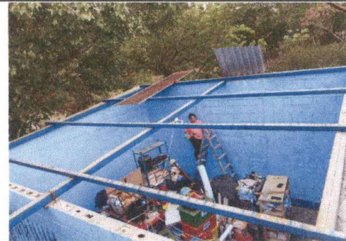
Foto 4: Sustitución de Lamina de la Biblioteca
