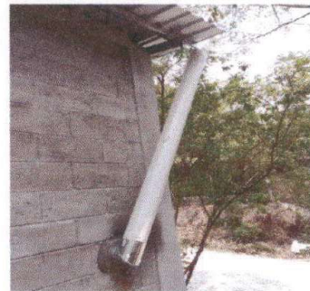
Foto 12: Sustitución de chimenea
