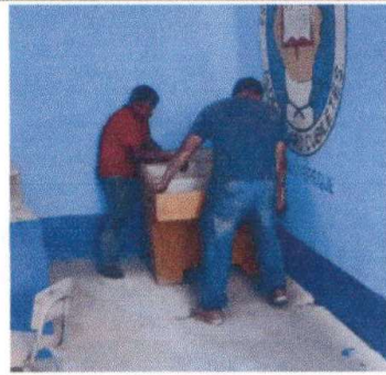
Foto 16: Sustitución de Pila
