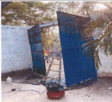
Foto 5: Pintura para portón
