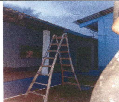
Foto 14: Sustitución de canal
