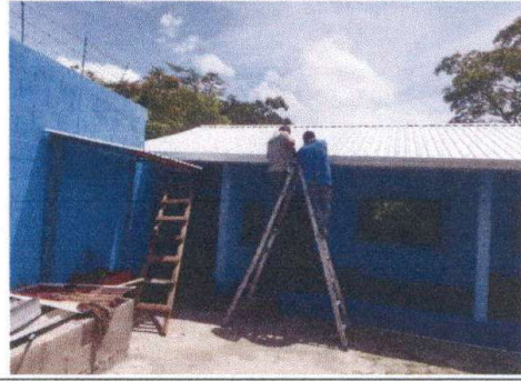
Foto 2: Canal de agua pluvia de la Cocina
