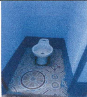
Foto 9: Sustitución de sanitario
