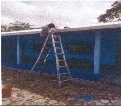
Foto 1: Canal de agua Pluvial corredor
