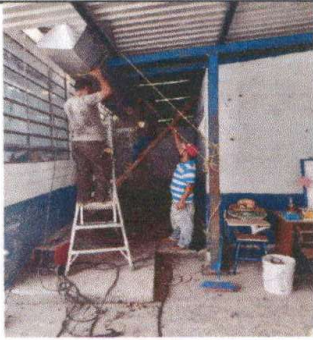
Foto 13: Sustitución de Canal
