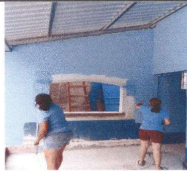
Foto 8: Pintura de interior y exterior
