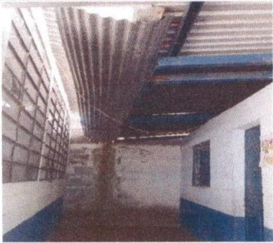
Foto 13: Sustitución de Canal
