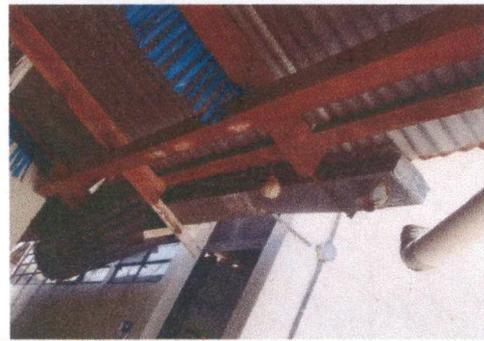
Foto 14: Sustitución de canal
