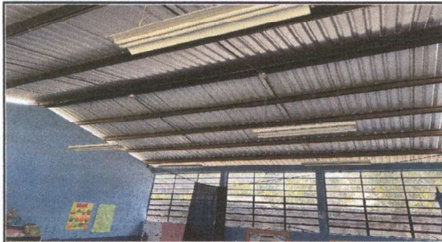
Foto 7: Sustitución de lámparas de 2 x 40
