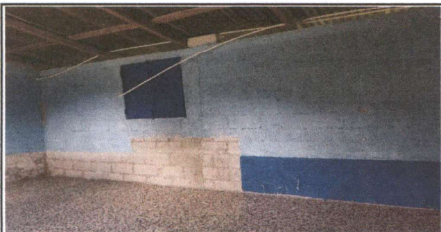
Foto 11: Repello de paredes de cocina
