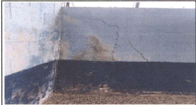
Foto 10: Repello de paredes de aula
