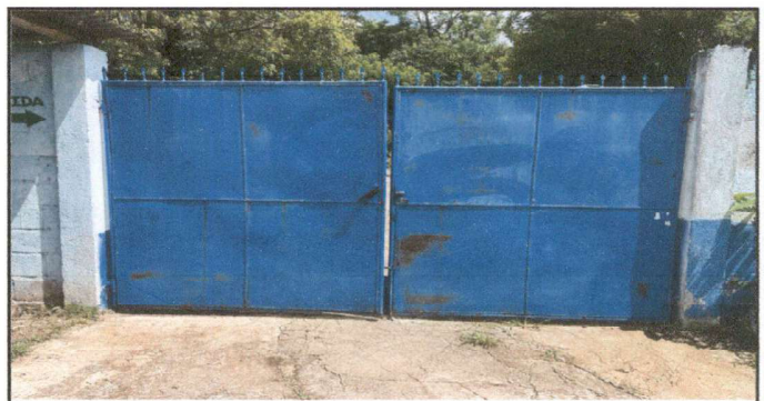
Foto 6: Mantenimiento a portón de metal
