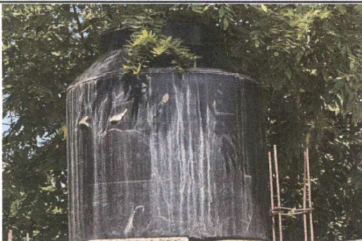
Foto 9: Sustitución de depósito de agua
