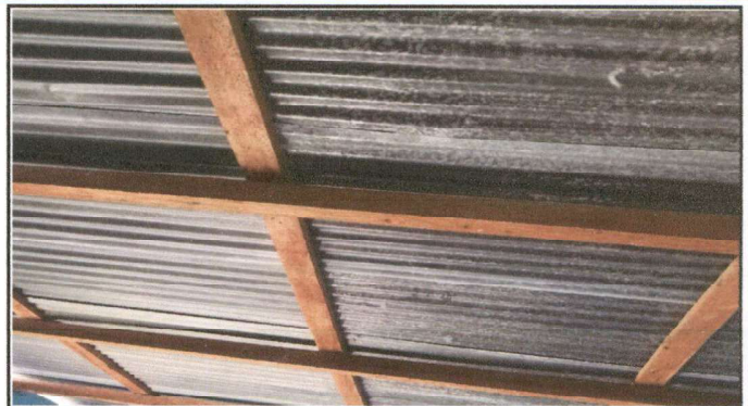
Foto 2: Sustitución de lámina, por lámina troquelada
