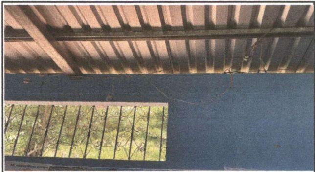
Foto 8: Reparación de cableado eléctrico
