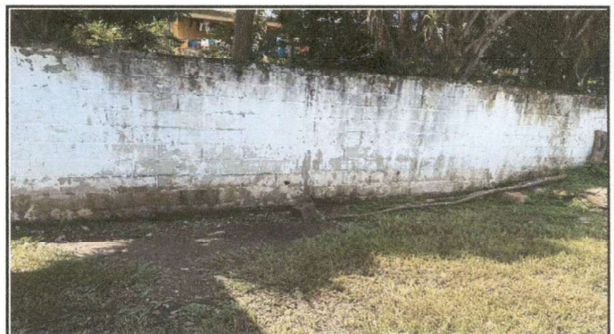
Foto 4: Pintura en muros exteriores e interiores
