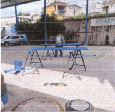
Foto 7: PINTANDO Y REPARANDO PUERTAS
