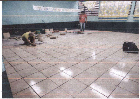
Foto 2: ALBAÑILES COLOCANDO PISO CERAMICO
