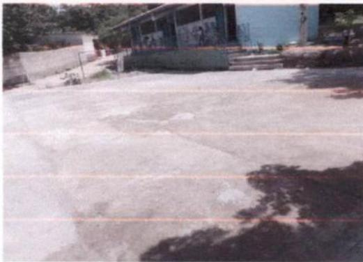
Foto 9: SUSTITUCIÓN DE TORTA DE CONCRETO TERMINADA
