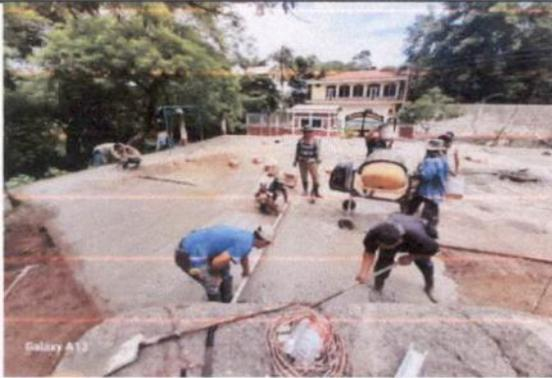
Foto 9: REPARANDO TORTA DE PATIO DE CONCRETO
