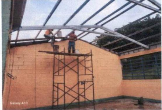
Foto 2: COLOCANDO COSTANERAS Y LÁMINAS NUEVAS
