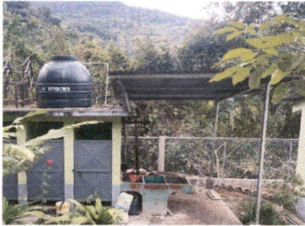
Foto1: Instalación finalizada de la cubierta de lámina y estructura de techo para la pila.
