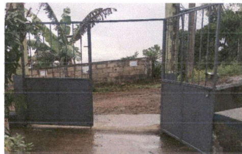
Foto 4: Mantenimiento de portón completado, lijado, ajustado, chapa nueva y pintura.
