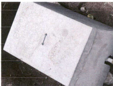
Foto 5: Instalación de la caja de registro del agua y sus llaves de paso.
