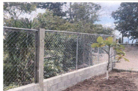
Foto 6: Muro perimetral completo de block y malla
