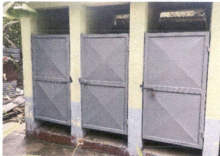
Foto 3: Mantenimiento completo de las puertas de los Sanitarios
