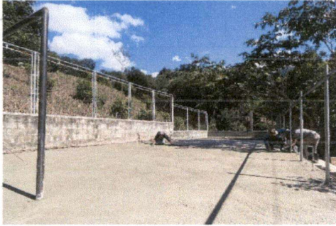
Foto1: losa de patio de concreto para área recreativa.
