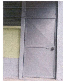
Foto 2: Mantenimiento completo de las puertas de las aulas, lijado y pintura.
