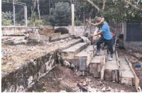
Foto1: mano de obra calificada en la fundición de las plancha de concreto.
