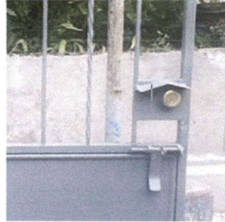
Foto 4: la colocación de chapa, lijado y pintura del portón
