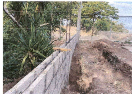
Foto 6: proceso de sustitución del muro perimetral.
