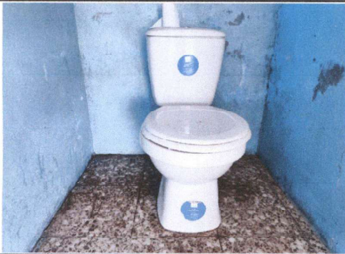
Foto 3: Sustitución de accesorios inodoro
