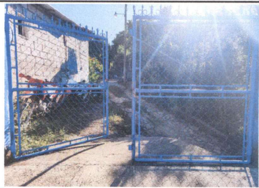
Foto 4: Mantenimiento a portones de metal
