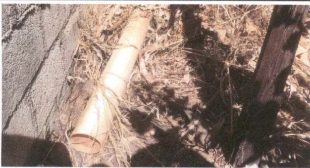
Foto 5: Sustitución de tubería PVC línea principal aguas pluviales (3 pulg o 4 pulg) y accesorios
