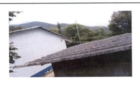
Foto 6: Sustitución de duralita por lámina troquelada calibre 26
