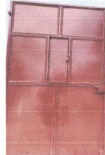
Repación de puertas
