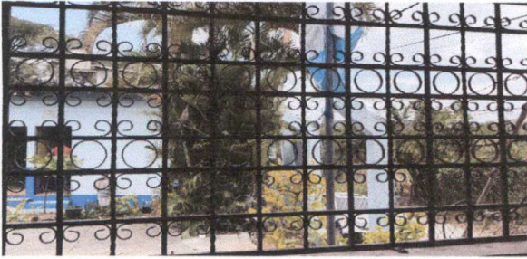
Foto 7: Mantenimeinto de balcones, pintura.
