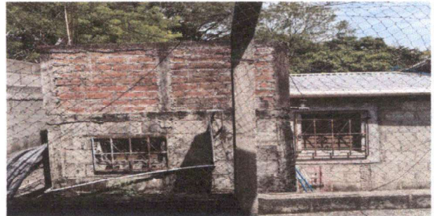
Foto 4: Reparación y ampliación de muro perimetral.
