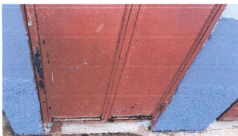
Foto 5: Sustitución de puertas de metal para sanitarios.
