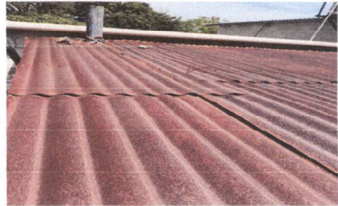
Foto 2: Sustitución de chimenea de la cocina.
