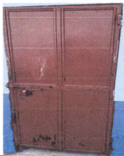
Foto 11: Mantemiento de puertas de metal.
