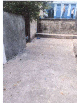
Foto 4: losa de patio
