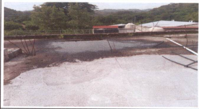
Foto 2: Acumulación de agua en la terraza.
